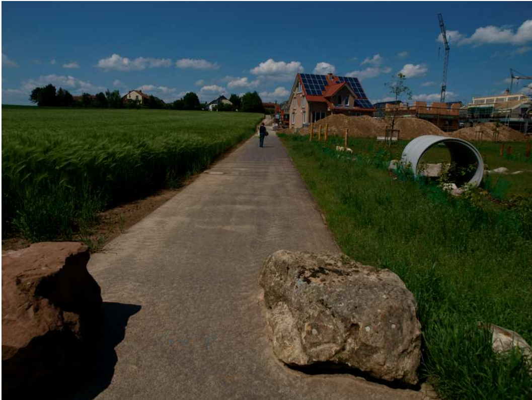
Bild 01: Plangebiet von Südosten (linke Bildhälfte, Weg und Baustraße gehören zum Plangebiet)
